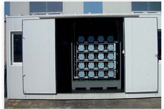
La configuración de la batería en celdas individuales y la fabricación propia del electrolito permiten conocer los parámetros de operación de cada celda en todo momento.
