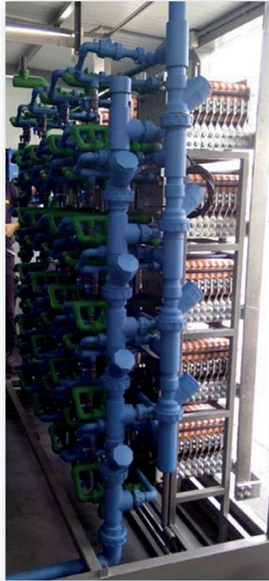
La celda Alfa de la planta, el sistema de tuberías y, arriba, los tanques con la solución de vanadio-plata.
