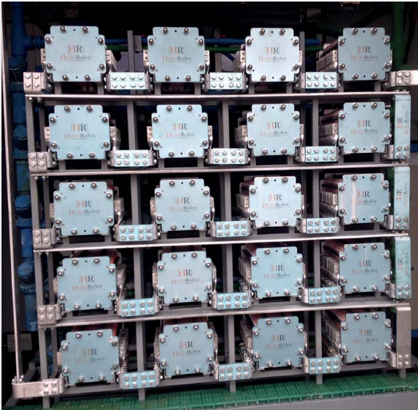
La configuración de la batería en celdas individuales y la fabricación propia del electrolito permiten conocer los parámetros de operación de cada celda en todo momento.
